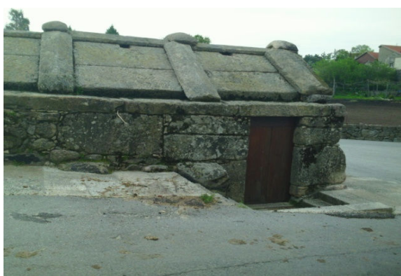
Fig. 5 - Exterior do Forno Comunitário
