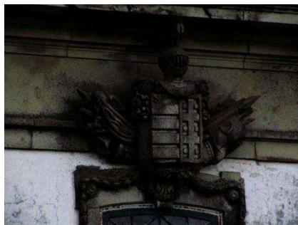
Imagem 18 - Pedra de Armas fachada principal - Casa das Agrads; Fonte: Autor;
