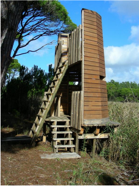
Figura 20: Exemplo de um observatório tipo torre com o posto de observação a dois níveis, um no topo e outro em baixo, funcionando simultaneamente como torre e varanda.
