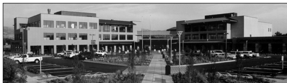
Figura 4. Hospital de Reabilitação Boulder Community [27].
