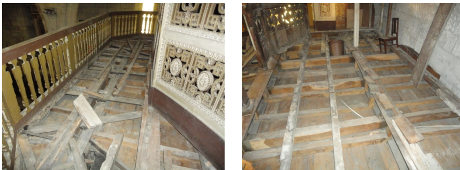
Figura 10 – Pavimento do coro alto após desmonte do soalho
