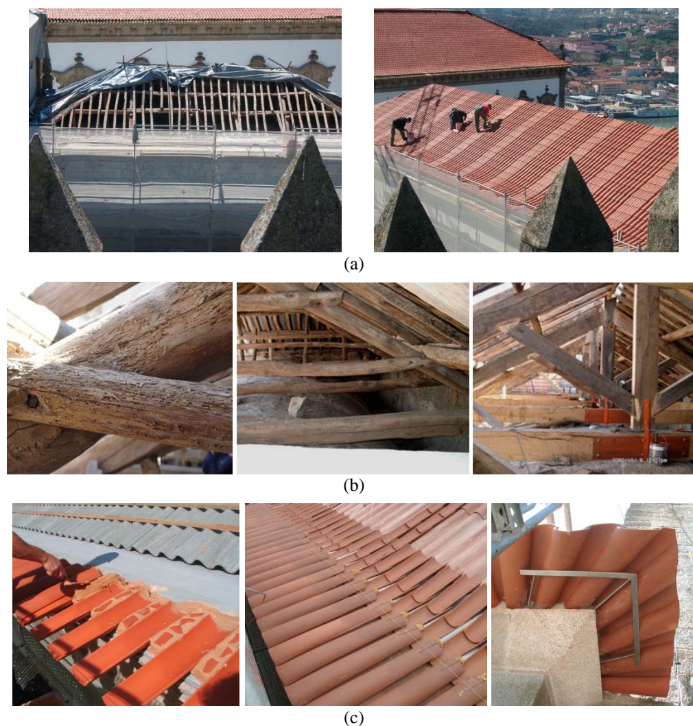
Figura 15 – Detalhes da execução: (a) cobertura durante e após a execução dos trabalhos; (b) detalhes da estruturas e reparações locais; (c) detalhes dos beirais e subtelha
