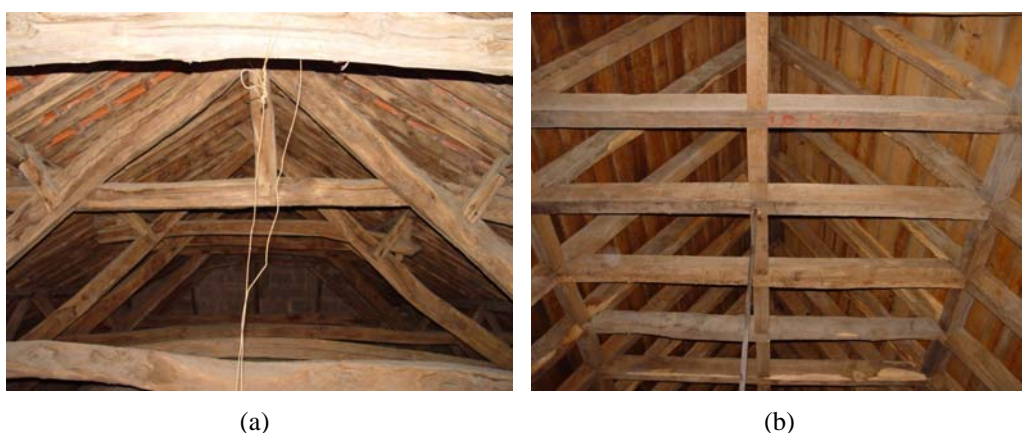
Figura 3 – Aspeto das coberturas: (a) pré-industrializada com secções roladas, Mosteiro de Arouca; (b) pós-industrializada com secções em esquadria, Paço dos Duques de Bragança
