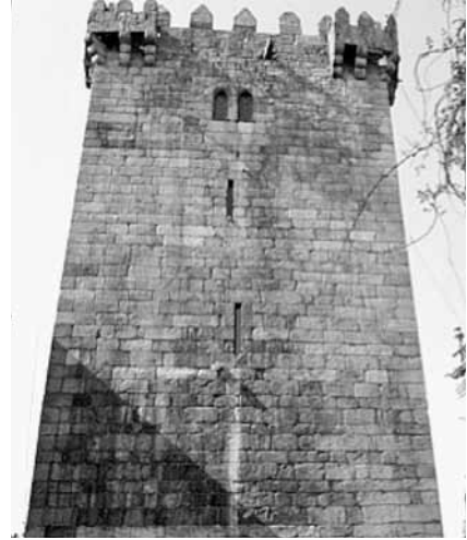
Figura 6. Torre de menagem do castelo medieval de Braga
