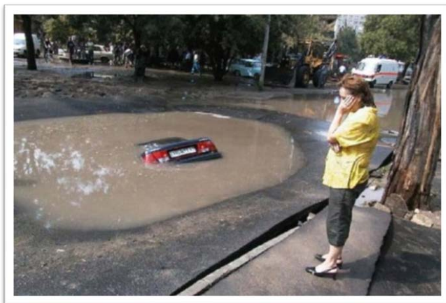
Figura 2-9 – Buracos em pavimentos podem evoluir para problemas mais sérios
