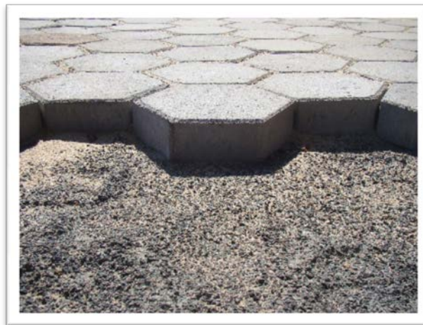
Figura 2-5 - Pavimento em ladrilhos sextavados
