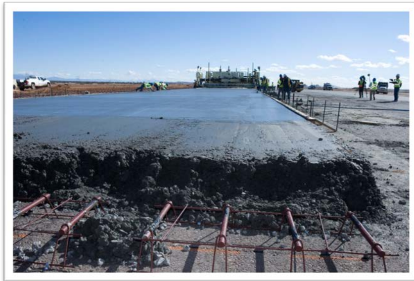
Figura 2-4 – Pavimento rígido em construção
