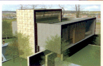
Moradia Isolada T4 S. Pedro D'Este - Braga - (Em construção)
