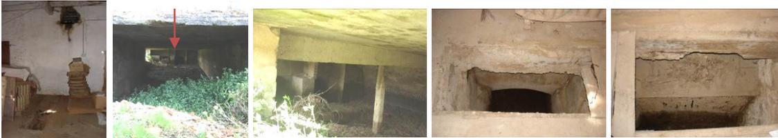
Figs 56 a 60 - Da esquerda para a direita: acesso à zona da turbina; canal da levada, sob o edifício, com indicação a vermelho, da entrada dos caboucos (da esquerda para a direita: desvio para o rio, alimentação do tanque de massa de papel primitivo e alimentação da turbina); pormenor das 3 entradas; pormenor da 2.ª entrada, vista do r/c; pormenor da 3.ª entrada com grade para retenção de detrito (eventual existência no seu interior do mecanismo original). Fotos de António França, 2009.
