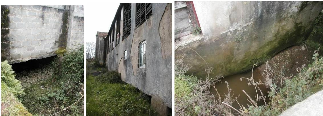
Figs. 49 a 51 - Sistema de circulação de água. Da esquerda para a direita: entrada da levada no edifício; aberturas entre os pilares, para acesso à levada; saída da levada, entre antiga casa do moinho e ponte, sendo perceptível as antigas entradas dos caboucos Fotos de António França, 2007
