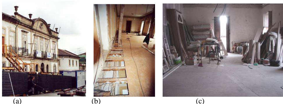
Figura 5: Pavimento em estudo: (a) vista do exterior do edifício; (b) pormenor dos vigamentos e da reabilitação; (c) aspecto do pavimento no final da operação de reabilitação
