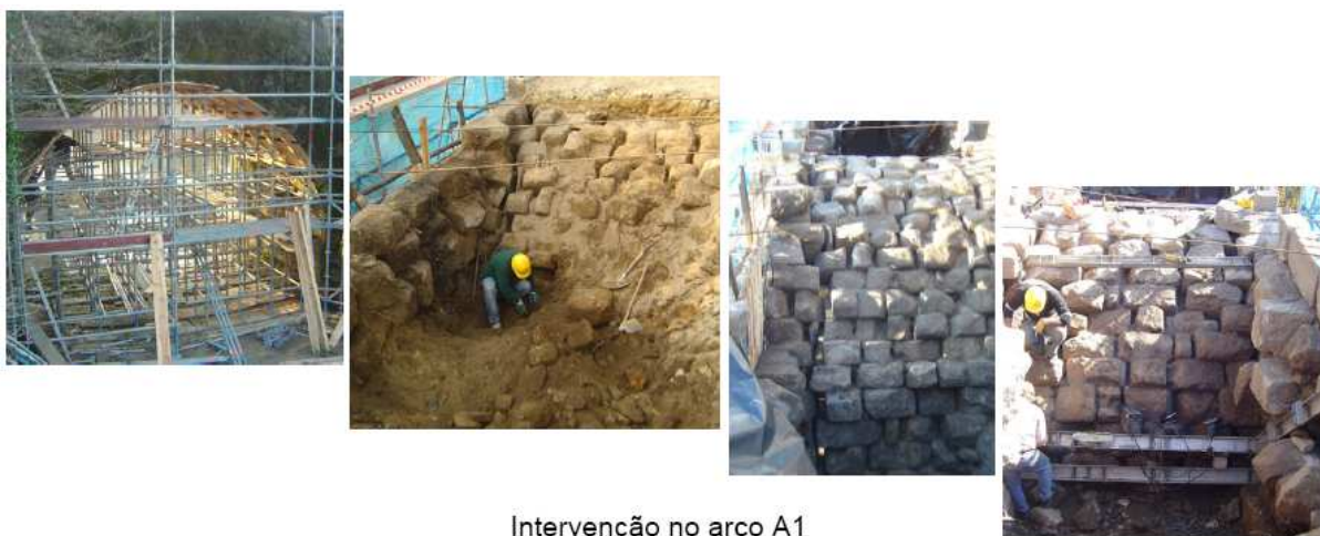
Figura 14: Reforço do arco de cheia: (a) pregagens radiais; (b) ancoragens transversais
