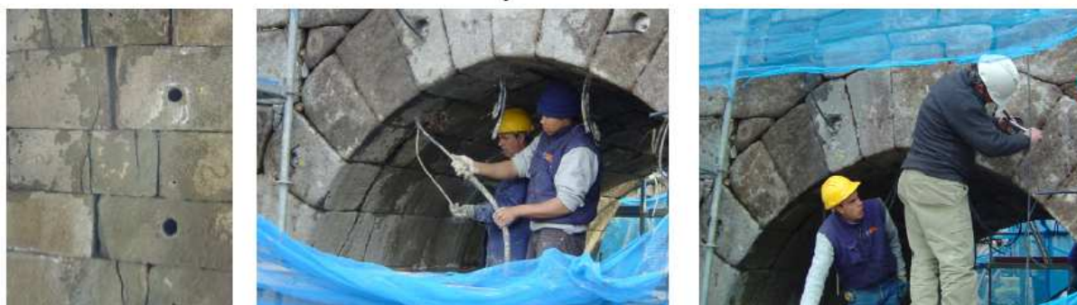
Ancoragem e pregagem do arco A4
