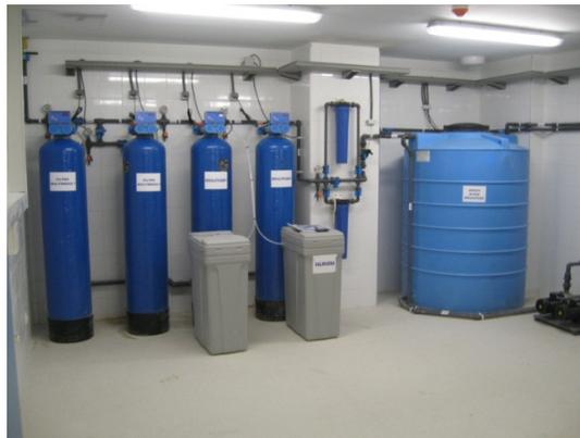
**Figura 3** - Sistemas de Tratamento de Água para diálise (Fonte: Hidropura)
