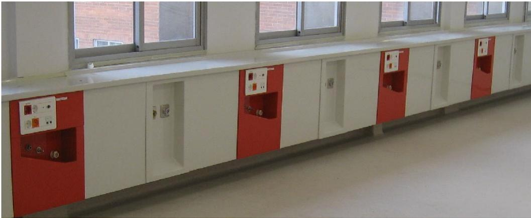
**Figura 4 - Painéis Técnicos para diálise (Fonte: Hidropura)**
