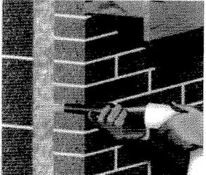
Figura 8. Exemplo ilustrativo da injeção de isolamento térmico na caixa-de-ar (HEAT USA, 2011)
