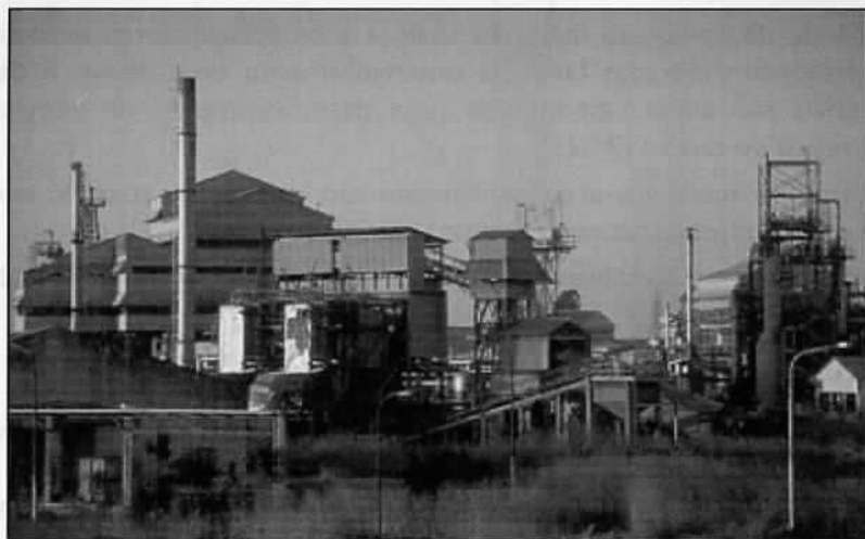
Figura 1 – Instalação industrial responsável pelo acidente de Bopal, Índia
