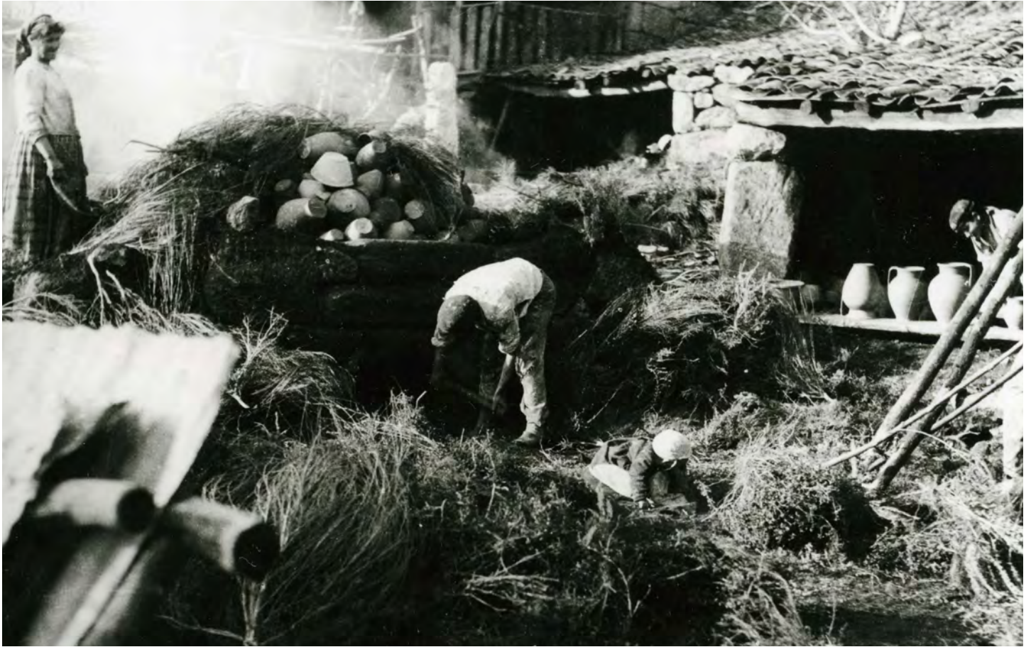
59 O enfornar da loiça. Ateia-se o fogo na caldeira. Séc. XX, 3.º quartel Putting the pottery in the kiln. The fire is lit in the boiler. 20 th century, 3 rd quarter
