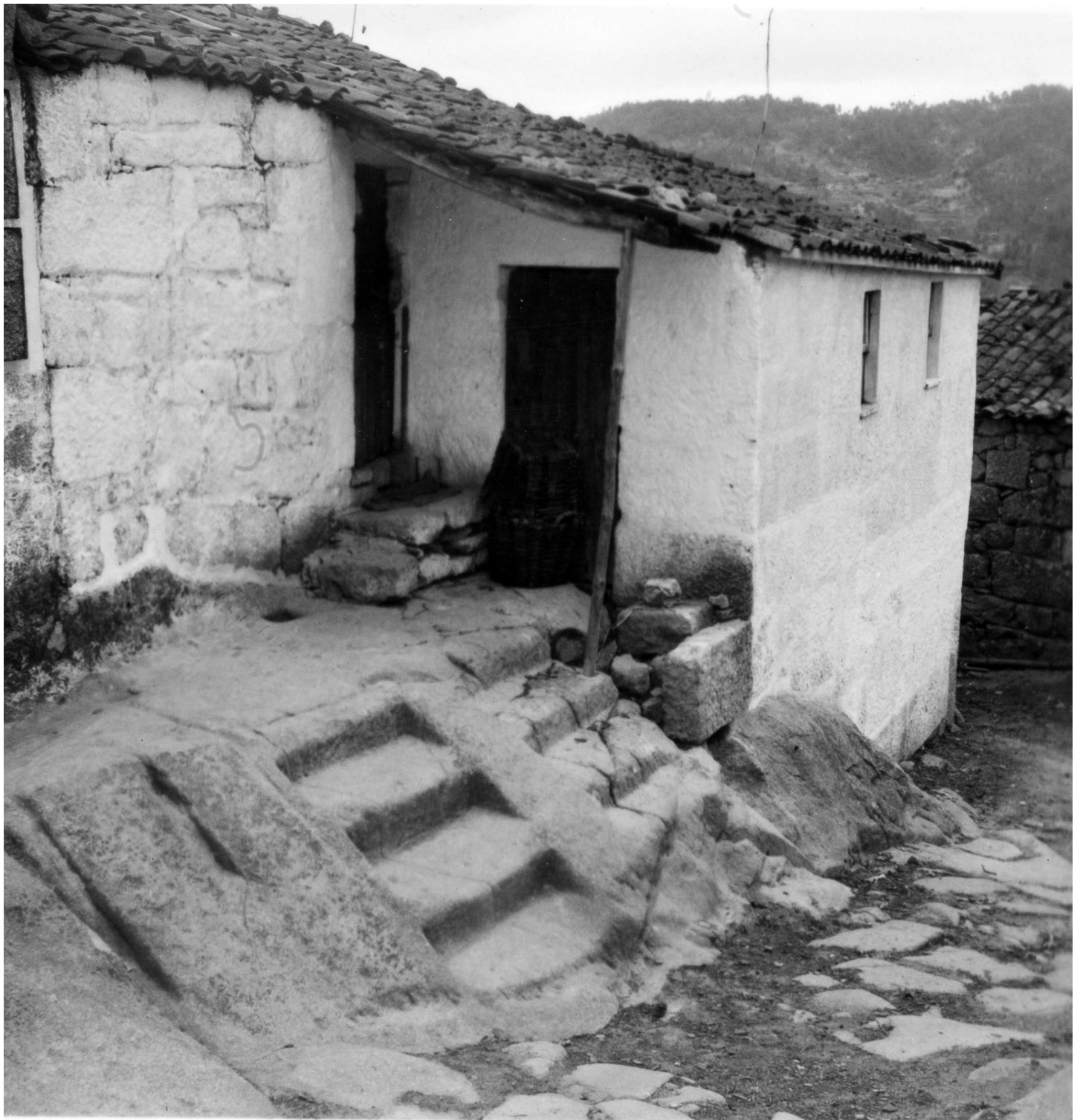
9 Uma velha casa no lugar de Bisalhães. Séc. XX, 3.º quartel An old house in Bisalhães. 20 th century, 3 rd quarter
