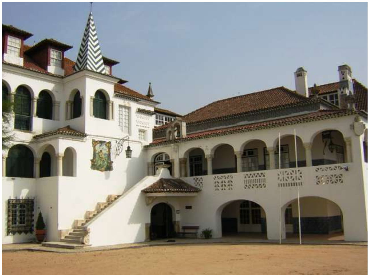
Fig. 8 Obras de Raul Lino, fotos do estado actual (E. F.). a) Vivenda Pimenta, Coimbra, 1902. | b) Governo Civil de Coimbra, 1928. c) Casa dos Patudos, em Alpiarça, 1904.
