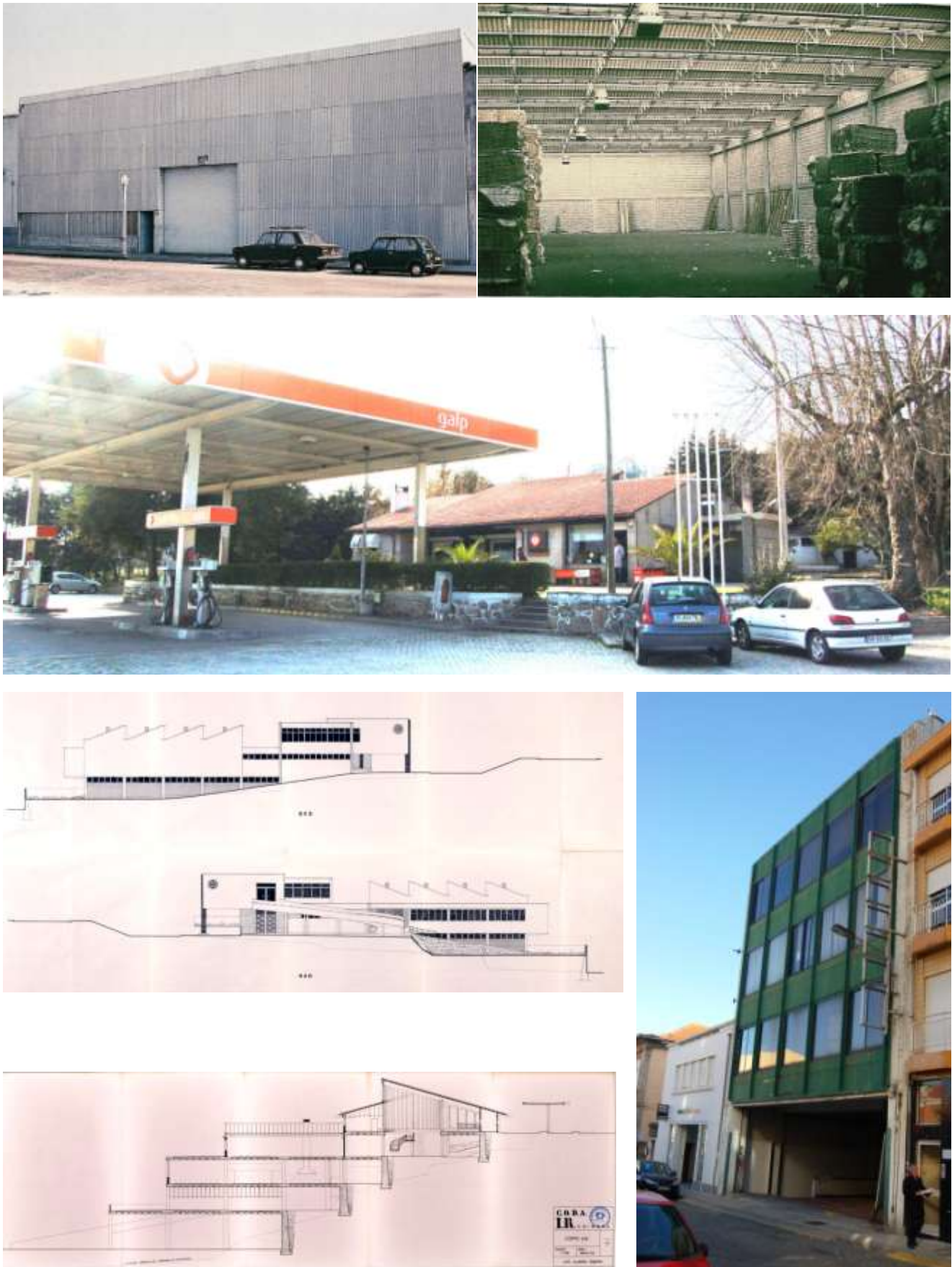
Fig. 79 a) Armazém de algodão em Matosinhos, Álvaro Siza, fotos do exterior e do interior (SALGADO, J., Álvaro Siza em Matosinhos , pág. 131). b) Restaurante e Posto de Estrada de Seia, Fernando Távora, foto do estado actual (E. F.). c) Agência "Volkswagen" em Braga, Aníbal Soares, alçados (CDUA FAUP). d) Estação de Serviço com Oficina, Luís Ribeiro, corte (CDUA FAUP) | e) Ampliação de garagem no Porto, Matos Ferreira, foto do estado actual (E. F.).
