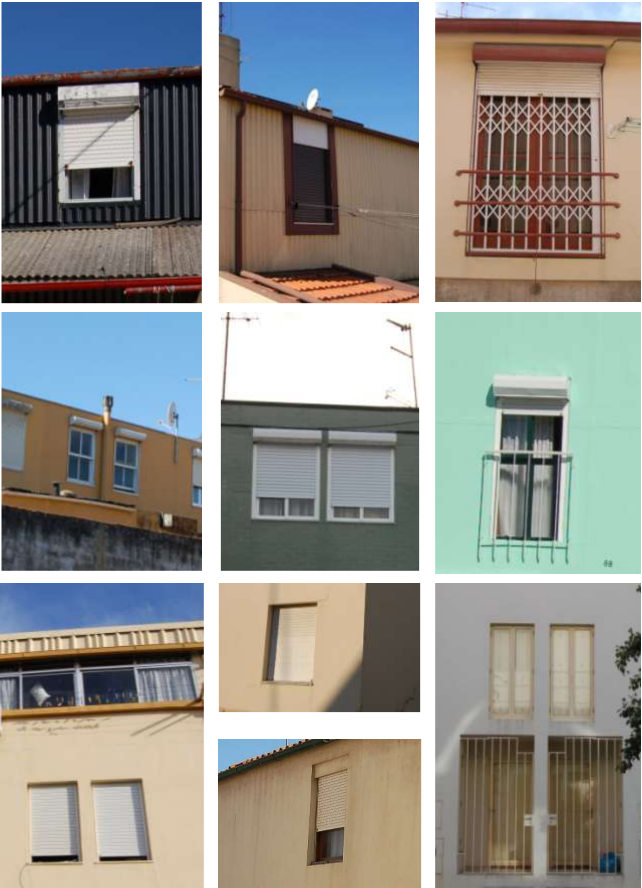
Fig. 122 Janelas dos bairros do SAAL construídos na cidade do Porto, fotos do estado actual (E. F.): a) Bairros das Antas, Contumil e Leal. b) Bairros da Maceda, Francos e Sra. das Dores. c) Bairros da Lapa, Massarelos, Chaves de Oliveira e Bouça.
