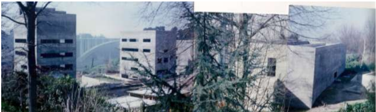
Fig. 154 FAUP, Porto, Álvaro Siza, fotos de três fases da construção (E. F.).
