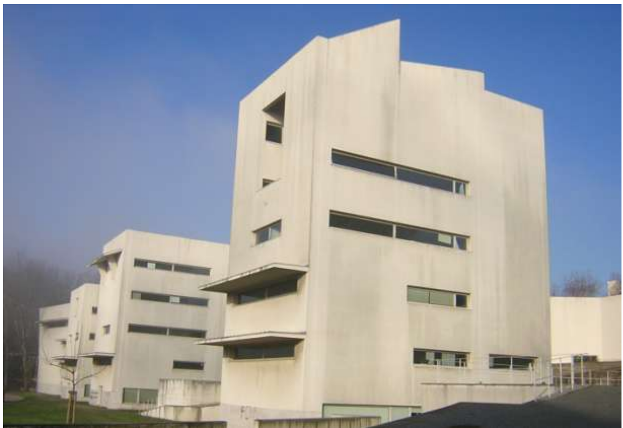
Fig. 159 a) campus de Otaniemi, Alvar Aalto, planta (LAHTI, L., Alvar Aalto , pág. 60). | b) FAUP, Álvaro Siza, planta (revista Croquis , n.º 68/69, pág. 166). c) casa Ozenfant, Paris, Corbusier (FRAMPTON, K., Le Corbusier , pág. 44) | d) casa Tzara, Paris, Adolf Loos (SARNITZ, A., Adolf Loos pág. 60) | e) "Grate-ciel" no bairro de Pessac, Bordeus, Corbusier, foto do estado actual (E. F.). f) FAUP, Álvaro Siza, foto do estado actual (E. F.).
