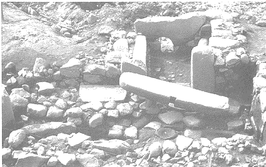
Fig. 5 - "Balneário" da Estação de Caminhos de Ferro (Braga). (Fotog. de Vladimiro Pires).
