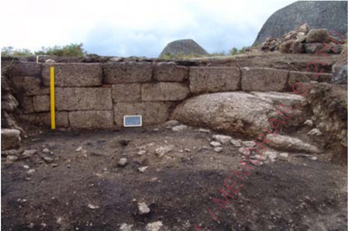
Foto 28 - Sondagem X200 Y200. Alçado da muralha.
