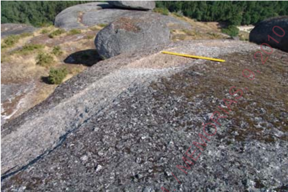
Foto 9 - Pormenor de rasgo para embasamento da muralha no lado Norte.
