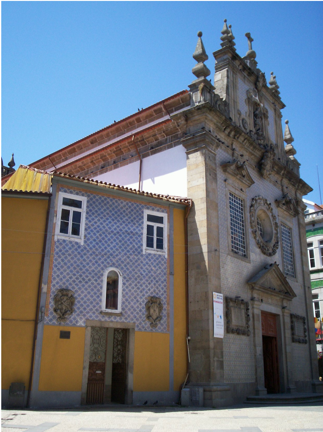
Figura 2.1.1 – Fachada da Igreja e anexos da Ordem Terceira de São Francisco, Braga
