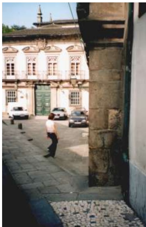
Figura V.4 – (a) Fachada principal do antigo Palácio dos Biscainhos; (b) Presença de crostas negras na fachada.
