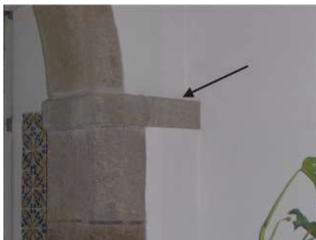
Figura II.8 – Local de colocação dos filtros receptores de deposição seca, no átrio da Reitoria da Universidade do Minho (antigo Palácio Arquiepiscopal de Braga).
