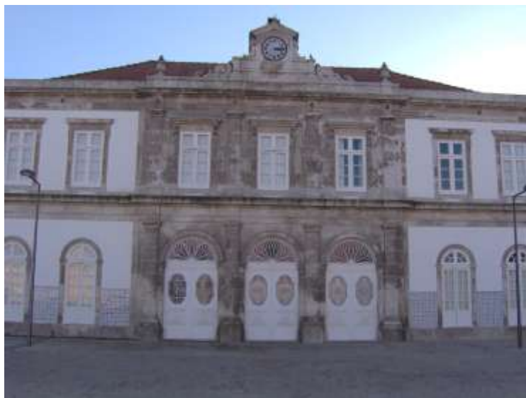
Figura V.8 – Estação dos Comboios (edifício antigo)
