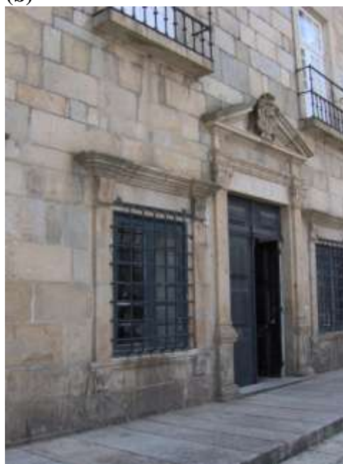
Figura V.3 – (a) Fachada principal do corpo renascentista; (b) Fachada lateral.
