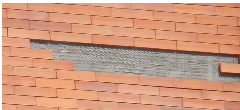
Figura 2.5 – Descolamento do cerâmico
