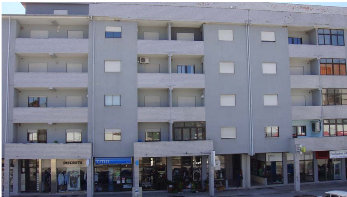
Figura 3.9 - Fachada Principal do Edifício Rossio
