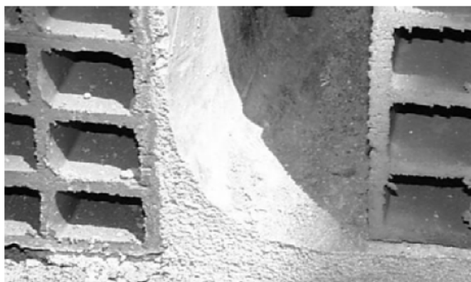
Figura 4.3 – Caleira bem executada [16]
