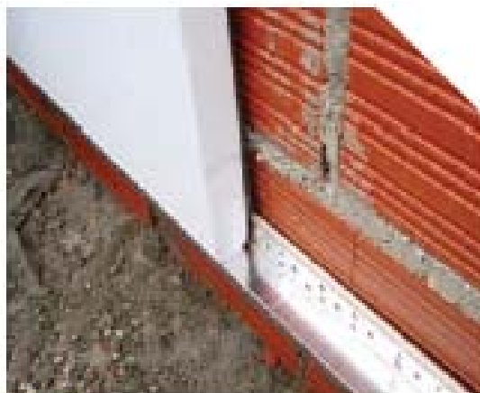
Figura 3.29 – Perfil de Arranque [31]
