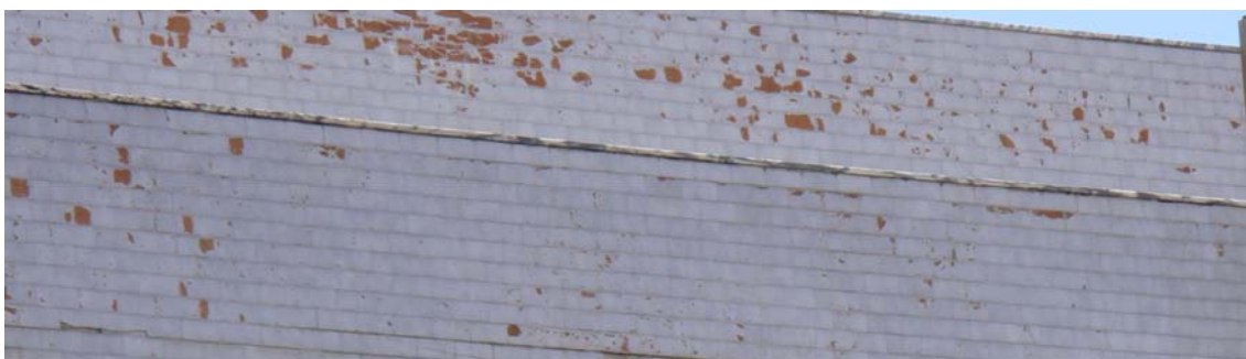
Figura 3.17 - Delaminação
