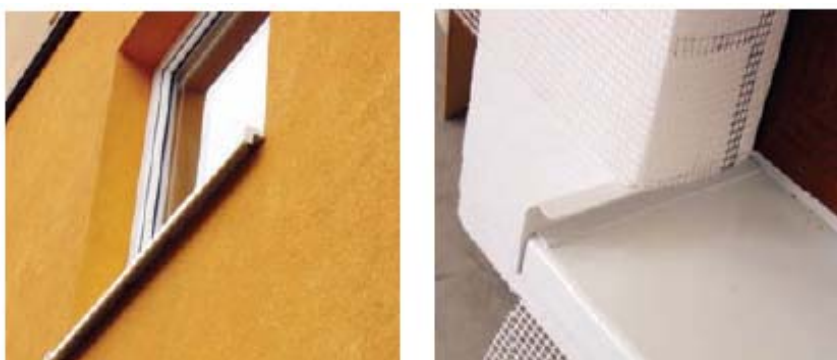
Figura 3.34 – Soluções para parapeitos em janelas [31]
