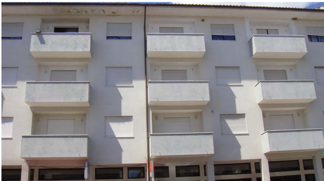
Figura 3.41 – Fachada principal do Edifício Amoreiras
