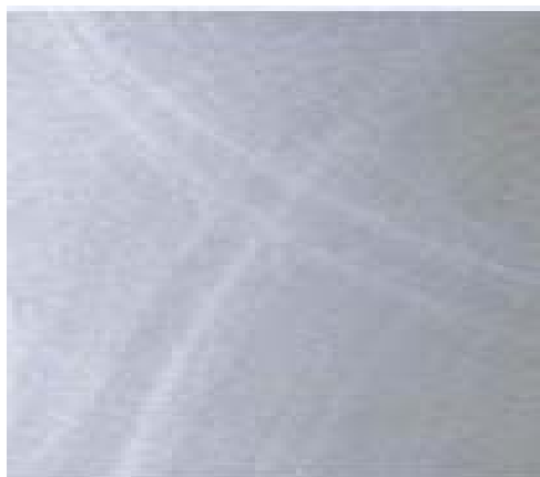
Figura 2.14 – Marcas de trincha
