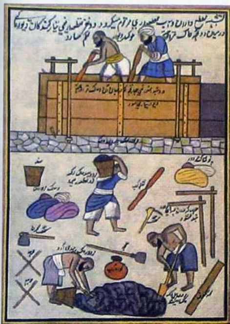
Figura 2: Manuscrito com pormenores da construção em taipa [5]
