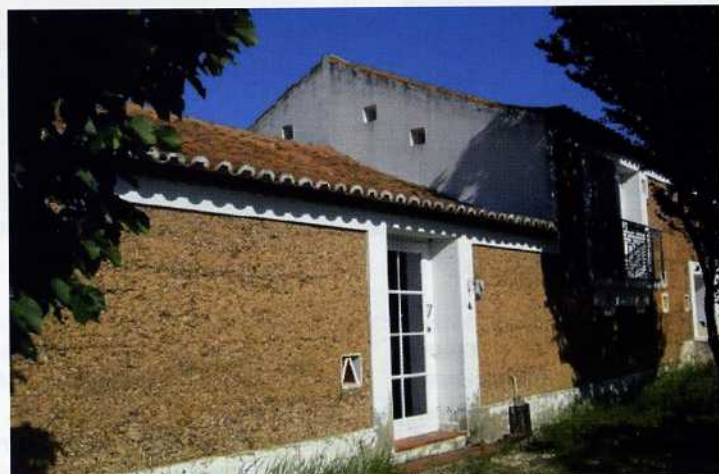
Figura 7: Habitação unifamiliar em Odemira com paredes de taipa [16]
