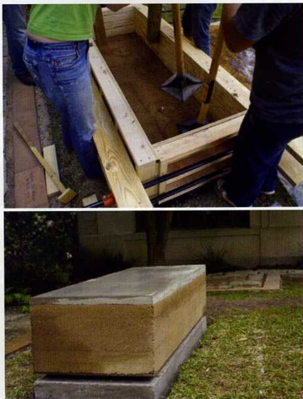
Figura 5: Construção de banco de jardim em taipa na Universidade do Texas
