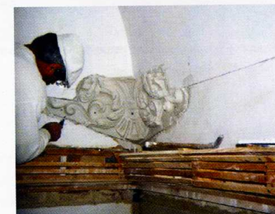
Figura 9: Colocação de ornamento em estuque [8]
