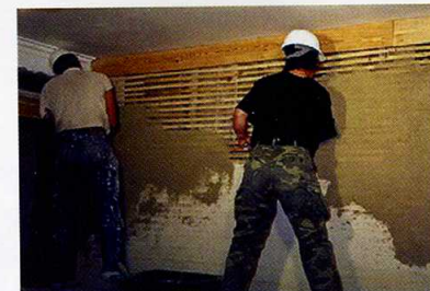
Figura 7: Revestimento do fasquiado com argamassa [8]
