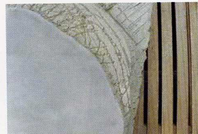
Figura 5: Revestimento de estuques antigos.
