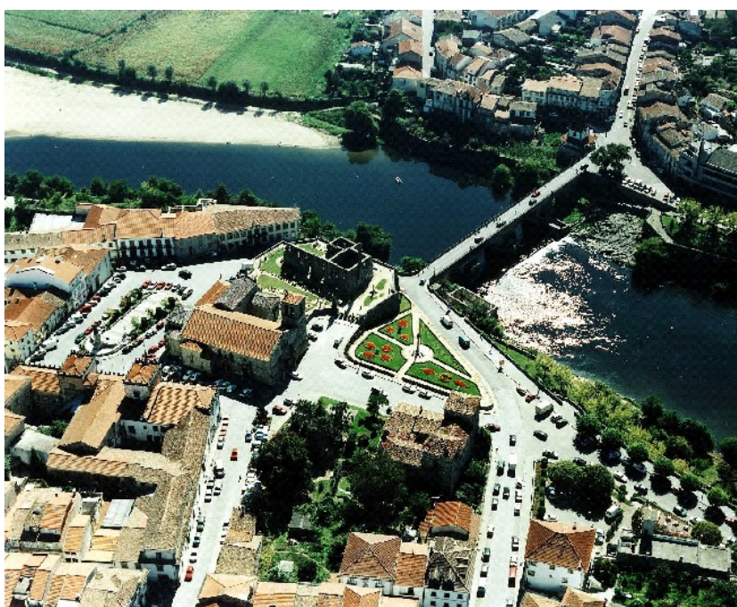
Vista aérea de Barcelos
